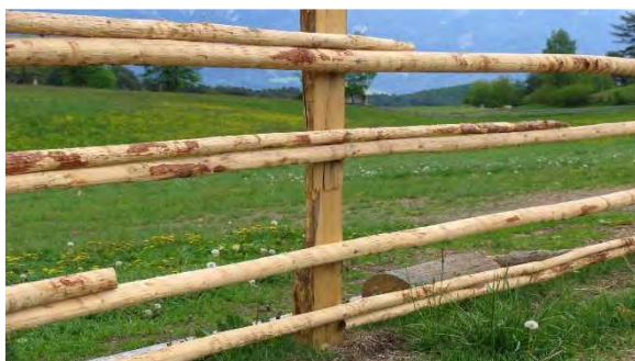
Bild 9: Stangen übereinander befestigt
