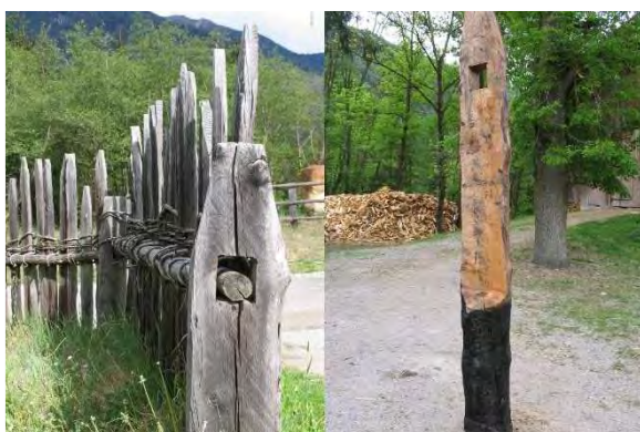
Bild 15: Speltenzaun und gelochte, angebrannte Säule
