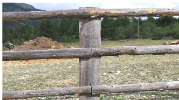
Bild 10: Stangen stumpf zueinander
