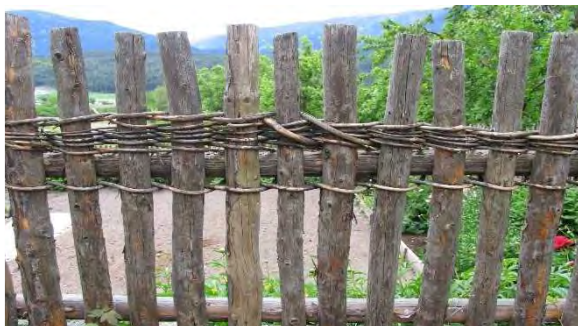
Bild 14: Speltenzaun mit geschnittenen Hölzern und einfacher Flechtung
