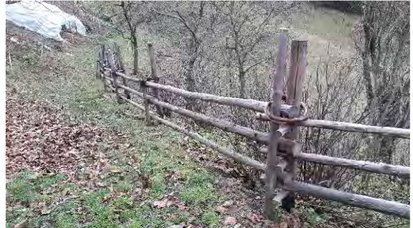
Bild 4: Stangenzaun mit Holznägeln und Weideband
